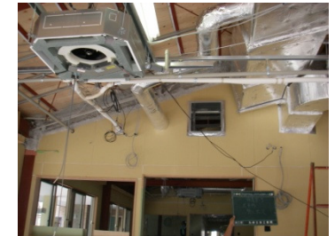
冬季：空気集熱暖房方式 夏季：空気排熱方式 (パッシブソーラーシステム)
