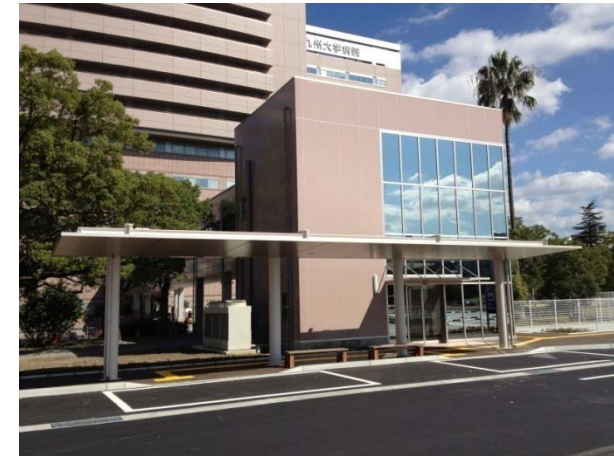
エレベーター棟外観
