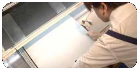
床板を外します
